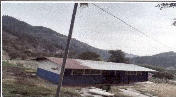
Foto1: Sustrucción de lámina troquelada aluzinc calibre 26
