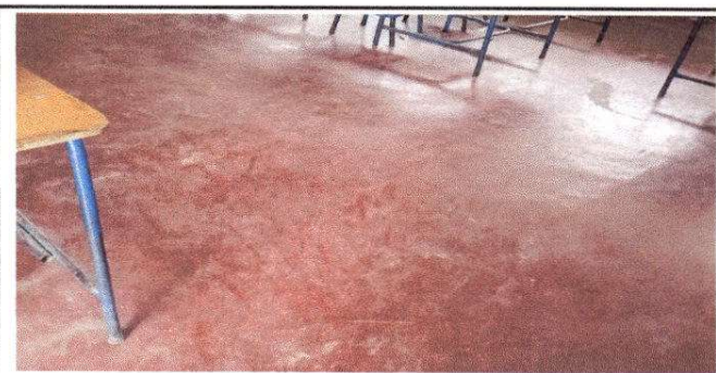
Foto 5: Sustrucción de piso de cerámico
