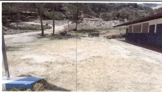
Foto 4: Sustrucción de piso de torta de concreto
